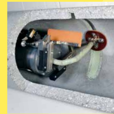
Spachtelroboter im Einsatz
