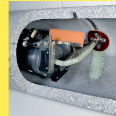
Der Spachtelroboter im Einsatz
