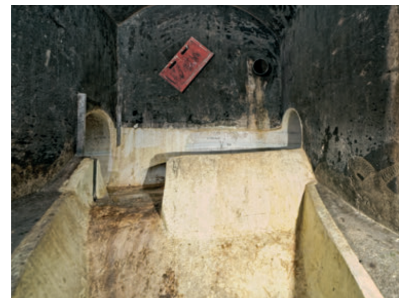
manuelle Schachtgerinne-Sanierung
